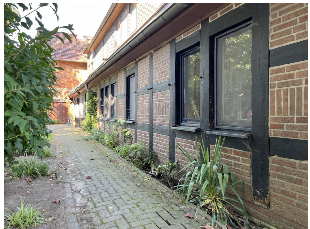
Wohnhaus seidl. Eingangsbereich
