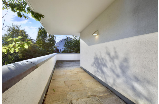
Balkon / Dachterrasse im 1. OG
