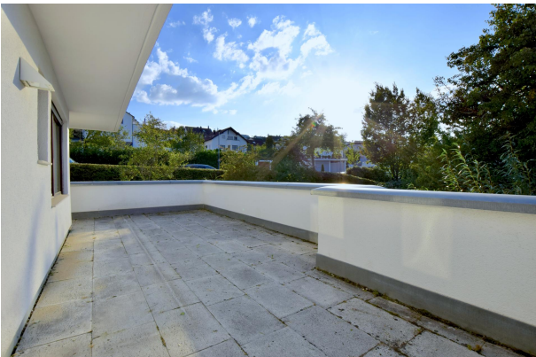
Balkon / Dachterrasse im 1. OG
